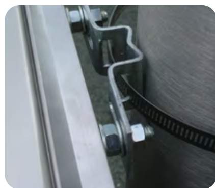
Fixation par feuillard inox
