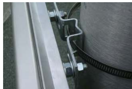
Fixation par feuillard inox
